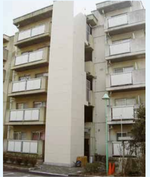
エレベーターの設置された南橋団地
