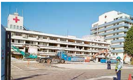
解体中の旧日赤病院
